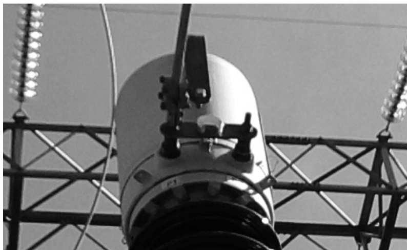
Fig. 7. Sistema ativo instalado em ponto quente de uma subestação.
